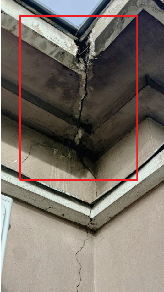
Fot.11. Rysy na spodzie wspornika stropodachu.
