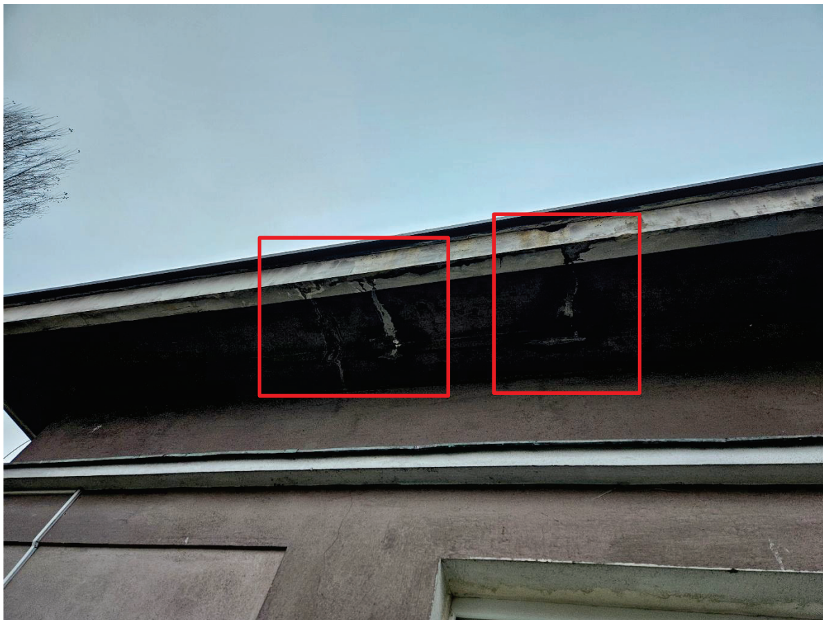
Fot.9. Rysy na spodzie wspornika stropodachu.
