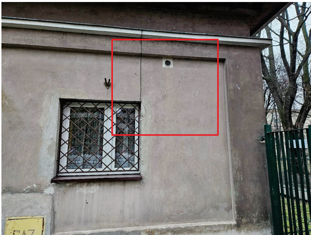
Fot.2. Rysy ukośne w narożach otworów okiennych.
