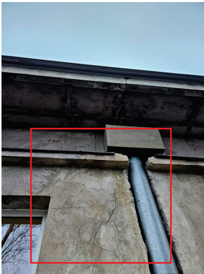
Fot.3. Rysy ukośne w narożach otworów okiennych, rysy na spodzie wspornika stropodachu.
