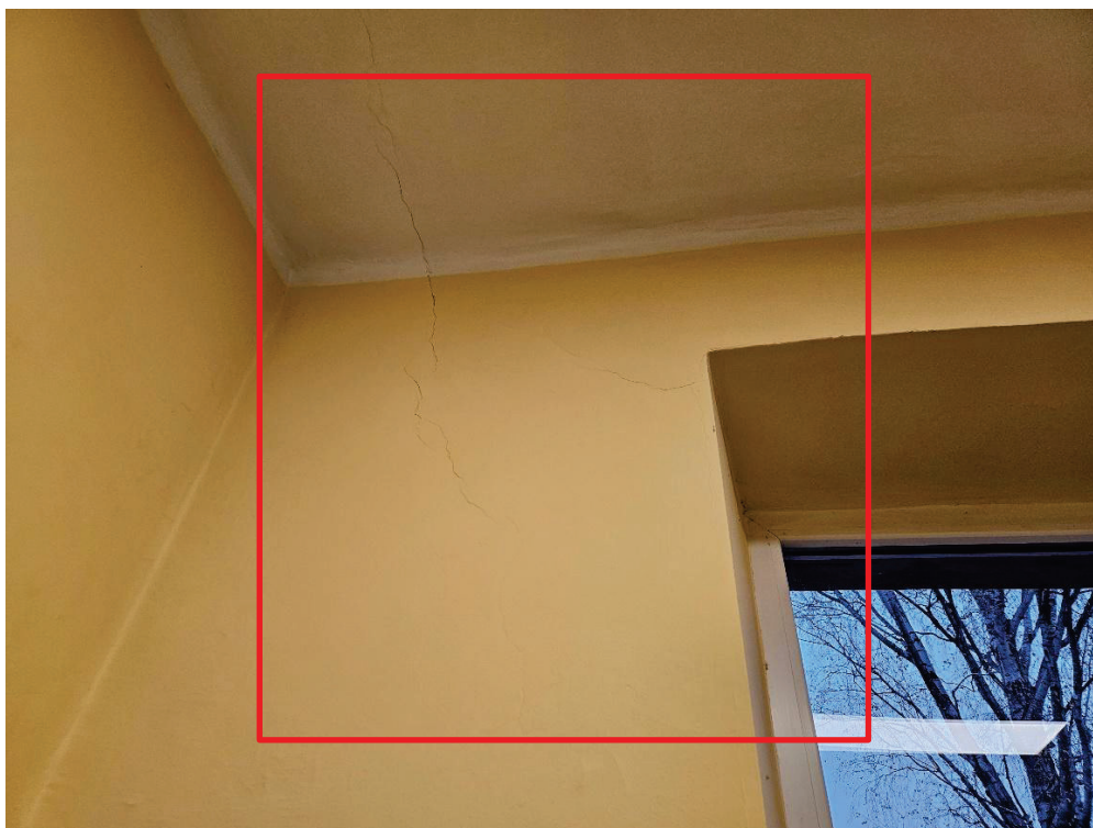
Fot.4. Rysy ukośne w narożach otworów okiennych obejmujące całą grubość ściany.
