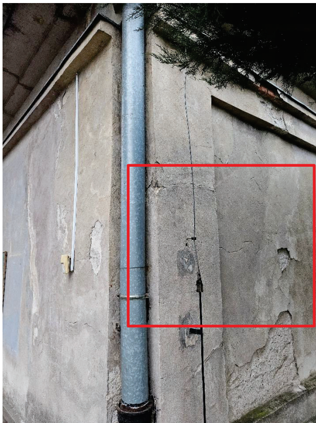
Fot.5. Rysy poziome i ukośne w narożu budynku.
