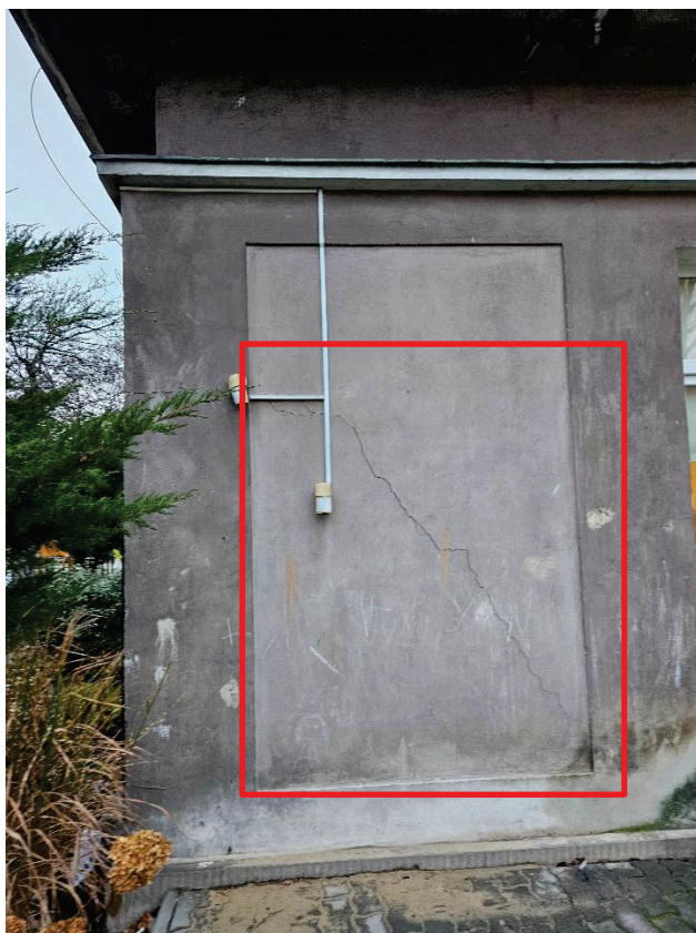
Fot.6. Rysy ukośne w niszach na ścianach.
