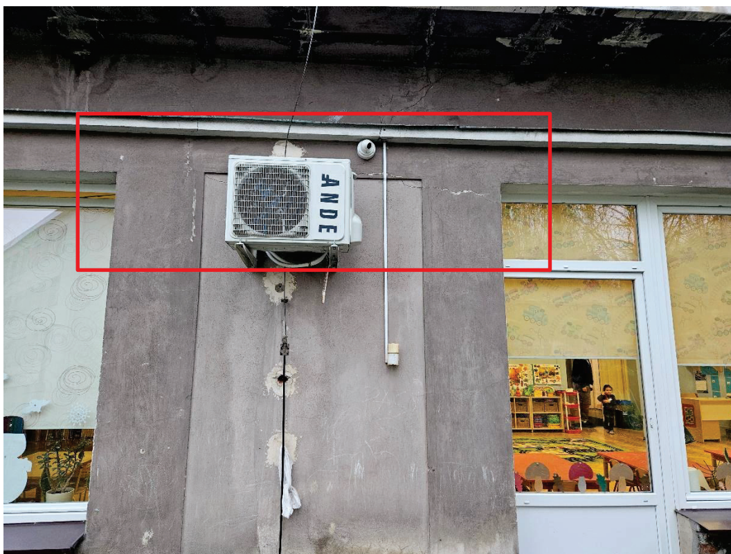
Fot.8. Rysy poziome na całej długości filarka międzyokiennego.
